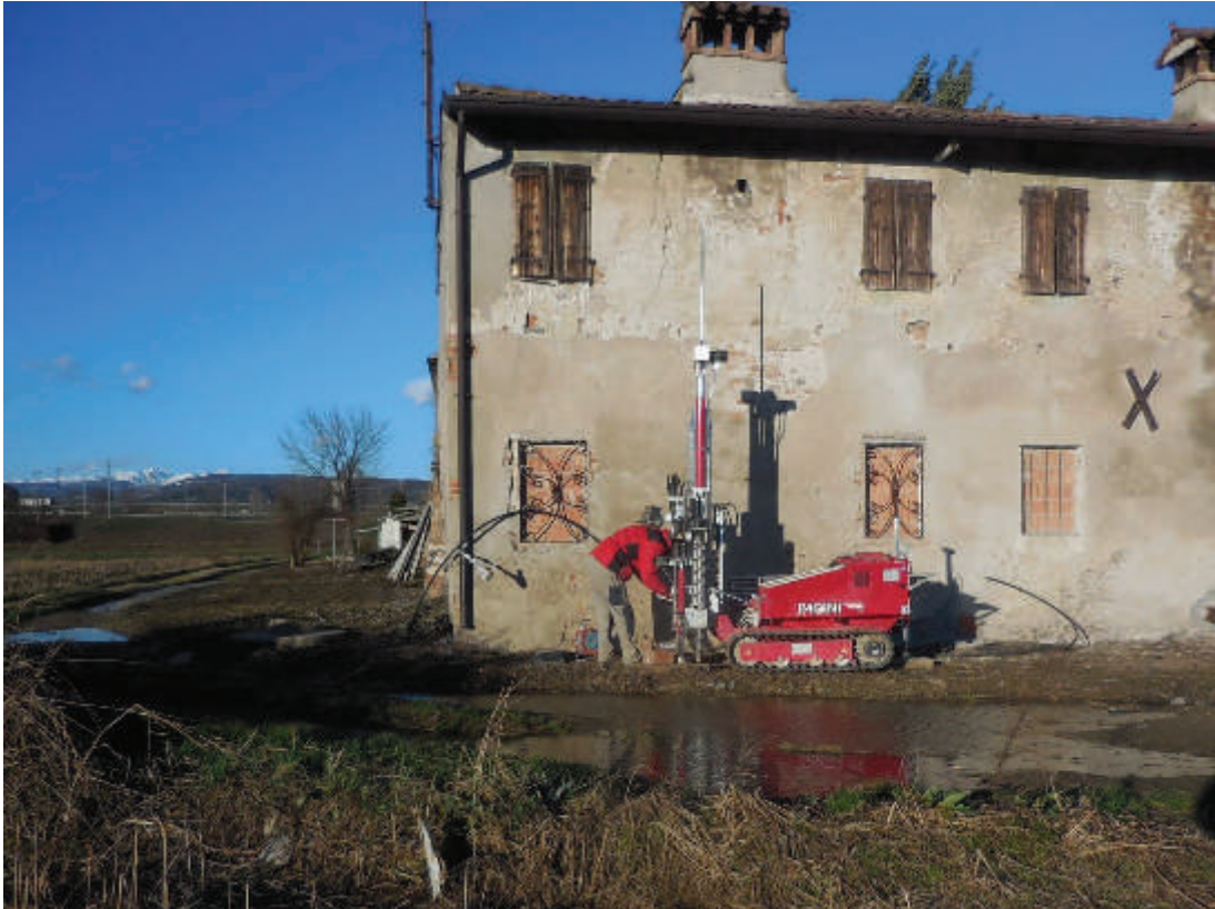
Fig. 6: esecuzione della prova penetrometrica DPSH 3.
